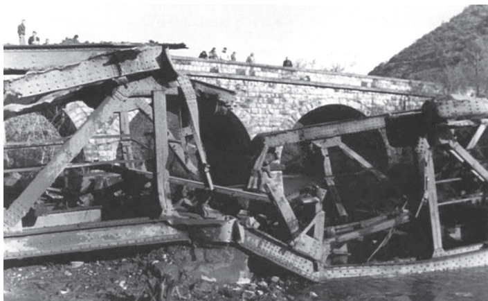
Срушени железнички мост Лопатница, пored каменог аутомобилског моста. 16
